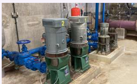
Les pompes alimentant le réservoir de Meyras
