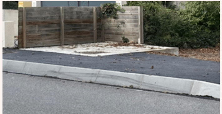
Emplacement du futur abribus
